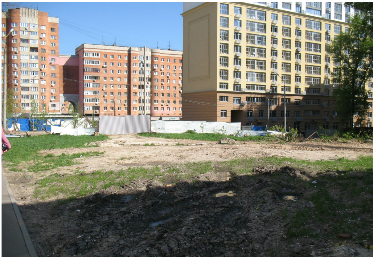
Фото 3. Огороженная территория участка строительства: справа— дом жилой (ул. Максима Горького, 73); в глубине— многоэтажная жилая застройка по четной стороне ул. Максима Горького.
