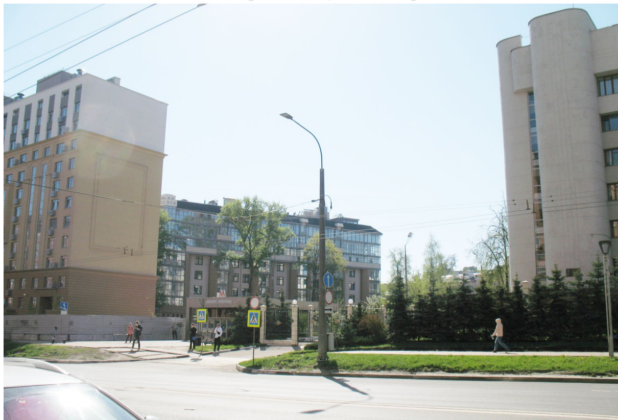
Фото 1. Вид с четной стороны ул. Максима Горького на участок строительства: справа – административное здание (ул. Максима Горького, 71); слева – дом жилой (ул. Максима Горького, 73); в глубине за участком строительства – жилой дом (ул. Максима Горького, 77)
