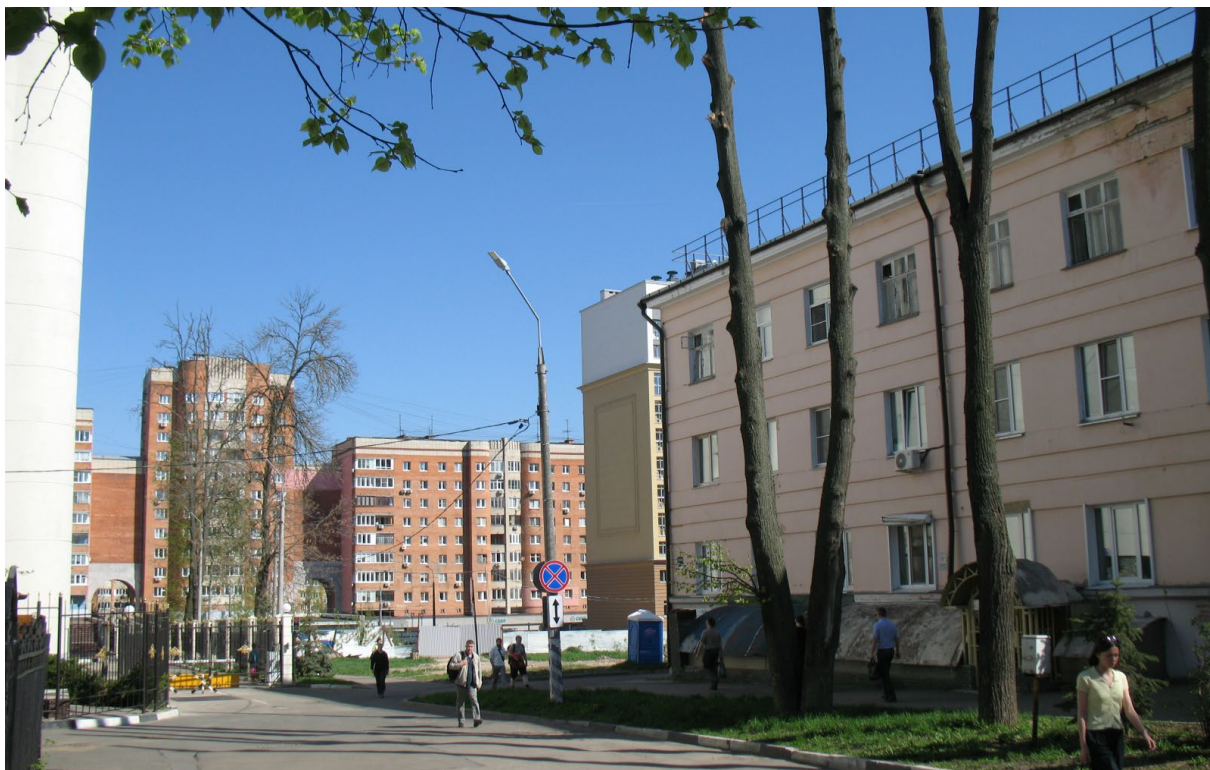
Фото 5. Вид от поворота ул. Короленко в сторону ул. Максима Горького: справа– трехэтажный жилой дом (ул. Короленко, 12); в глубине– огороженная территория участка строительства.
