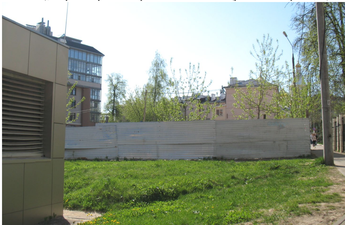
Фото 2. Вид от павильона метро «Горьковская». Огороженная территория участка строительства.
